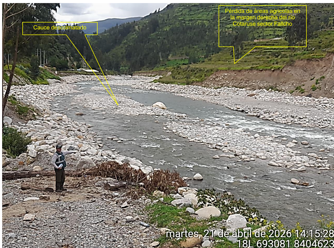
Imagen 1. Tramo crítico en el sector Falcho hacia la margen derecha del río Cotaruse, con erosión de talud y pérdida de áreas agrícolas con cultivo de maíz
