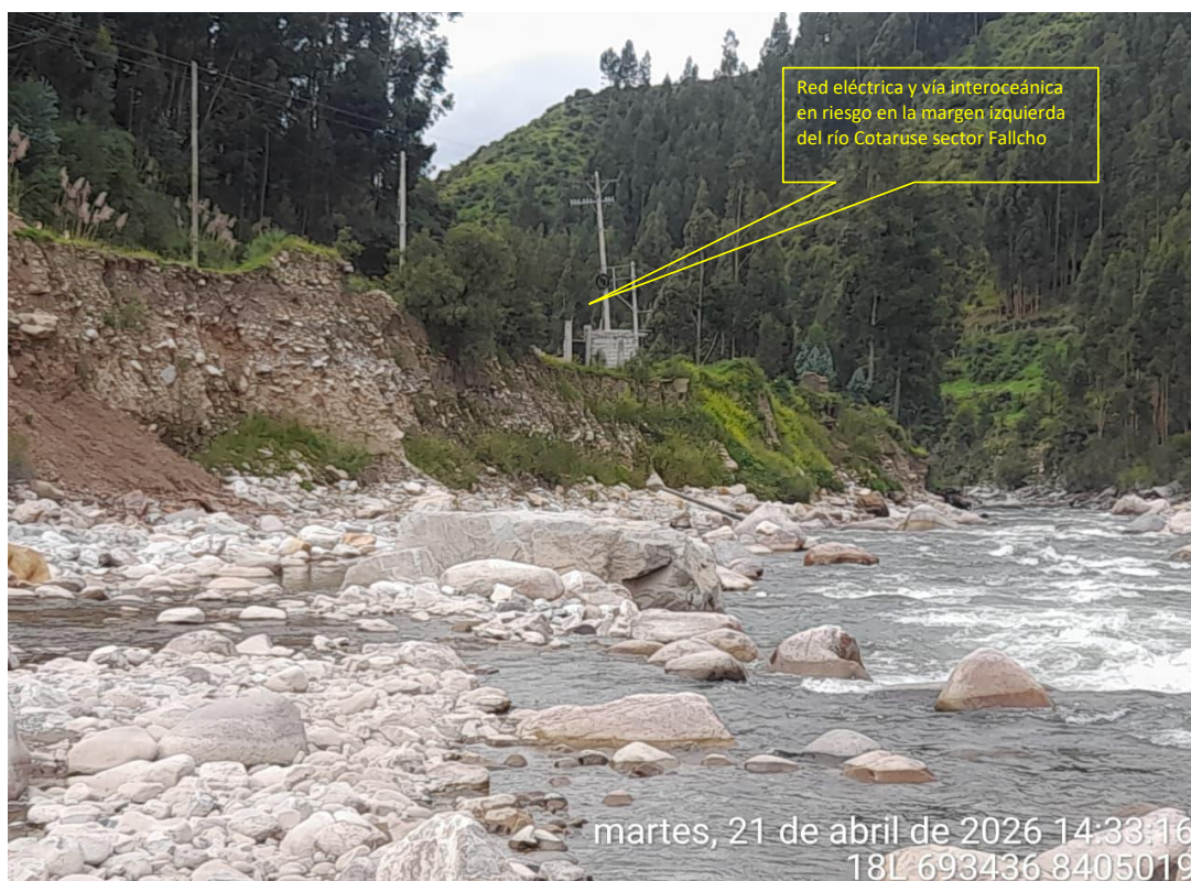
Imagen 2. Tramo crítico en el sector Falcho en la margen izquierda del río Cotaruse, con erosión de talud, red eléctrica y vía asfaltada interoceánica en riesgo.
